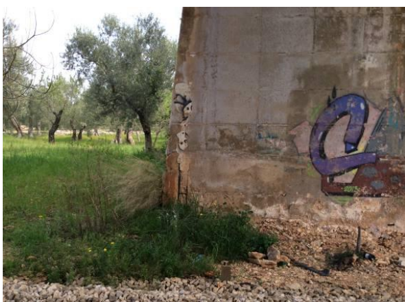
Calcestruzzo degradato delle spalle e della soletta dell'impalcato
