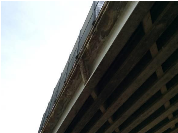
Calcestruzzo degradato delle spalle e della soletta dell'impalcato
